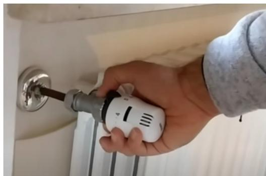
**2. Sbloccare il perno della valvola:** Utilizzando una pinza, afferrate il perno centrale della valvola (di solito un piccolo cilindro che dovrebbe sporgere leggermente) e provate a spingerlo e tirarlo con delicatezza. Il movimento dovrebbe essere fluido, in quanto il perno deve potersi muovere liberamente e tornare alla sua posizione originale dopo essere stato premuto.
