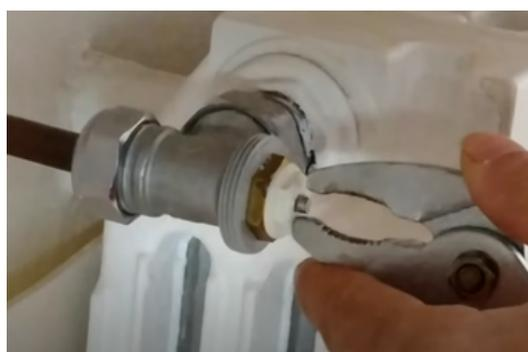
**3. Rimontare la testina termostatica:** Una volta sbloccato il perno, riavvitate la testina termostatica sulla valvola. Dopo aver eseguito questa operazione, il termosifone dovrebbe tornare a scaldarsi normalmente.
